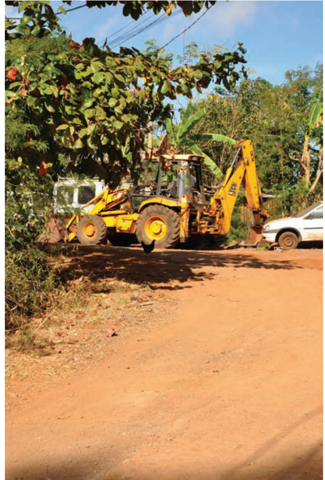
Figure 6: La pelle mécanique sur site.
